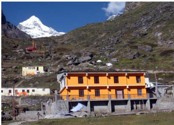
Der im Bau befindliche Ashram in Badrinath (Oktober 2015)
