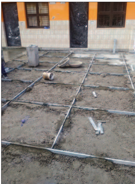
Construction d'une passerelle étanche
