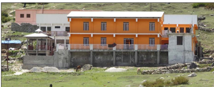
Le nouvel Ashram à Badrinath.
