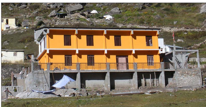
Ashram en construction à Badrinath.
