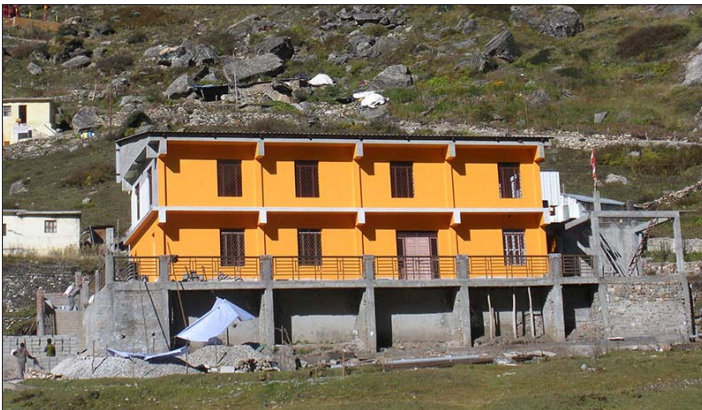
Ashram en construction à Badrinath.
