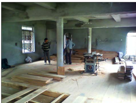
Albert Vogt et les charpentiers préparent le bois franc «shal» pour le plancher de la salle de méditation.
