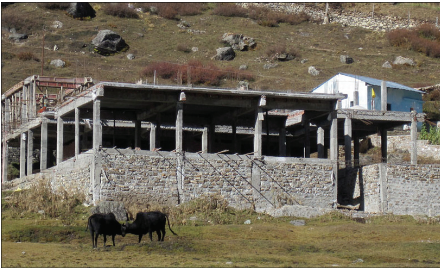
Construction de l'Ashram à Badrinath.
