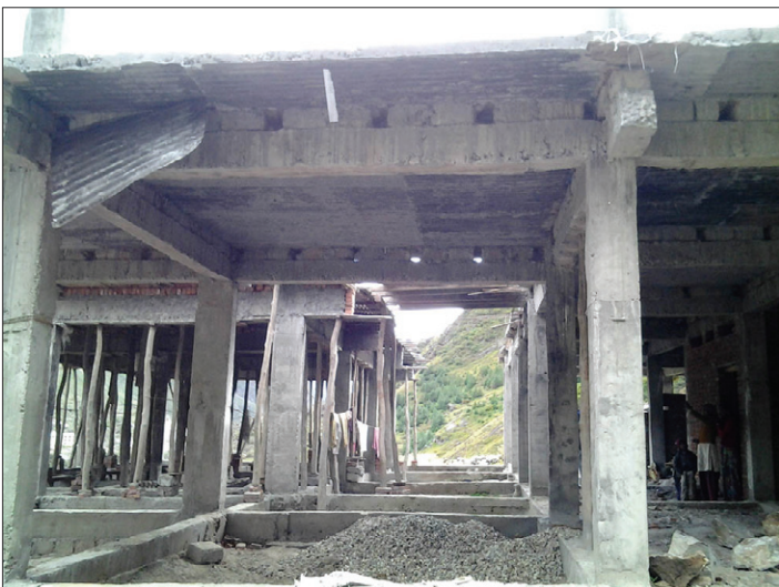
Dalles de ciment pour le plafond de la salle de méditation à gauche, et les appartements avec leurs portiques à droite.
