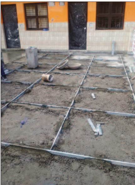
Construcción de una pasarela impermeable.
