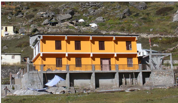
Ashram en construcción en Badrinath.
