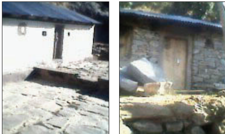
Nuevas casas construidas.
