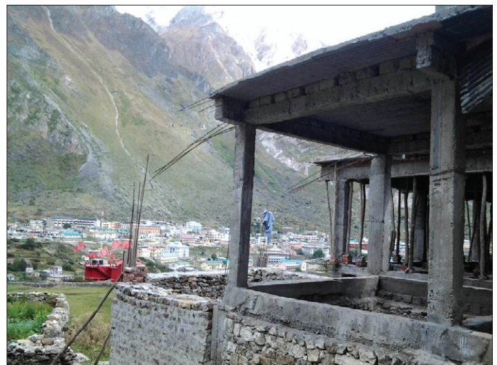
Esquina noreste: pilares para la oficina/librería, y detrás la sala de meditación.
