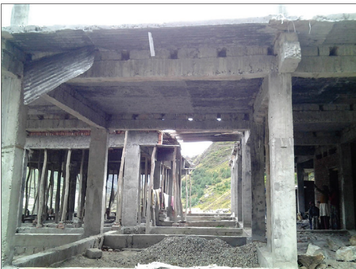
Losas de cemento para el techo de la sala de meditación, a la izquierda, y a la derecha los apartamentos y sus pórticos.
