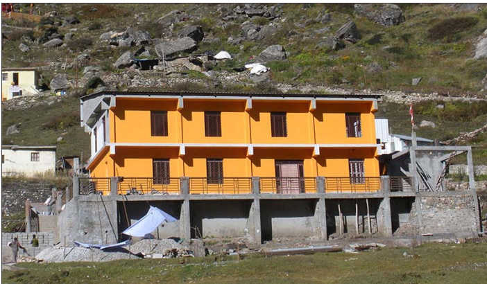
Ashram en construcción en Badrinath.
